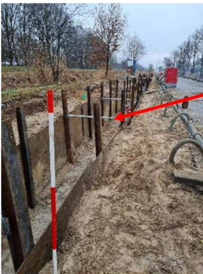
foto 1 juist geplaatste sleufbekisting gebruik gemaakt van H-binten i.c.m. rijplaten
